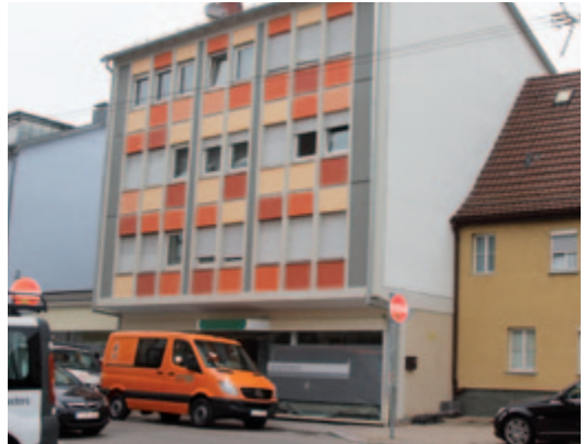
Harald Giese ließ das Gebäude komplett renovieren
