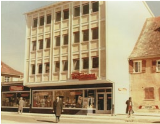
Das Geschäftshaus in der Rubensstraße in den 50er Jahren
